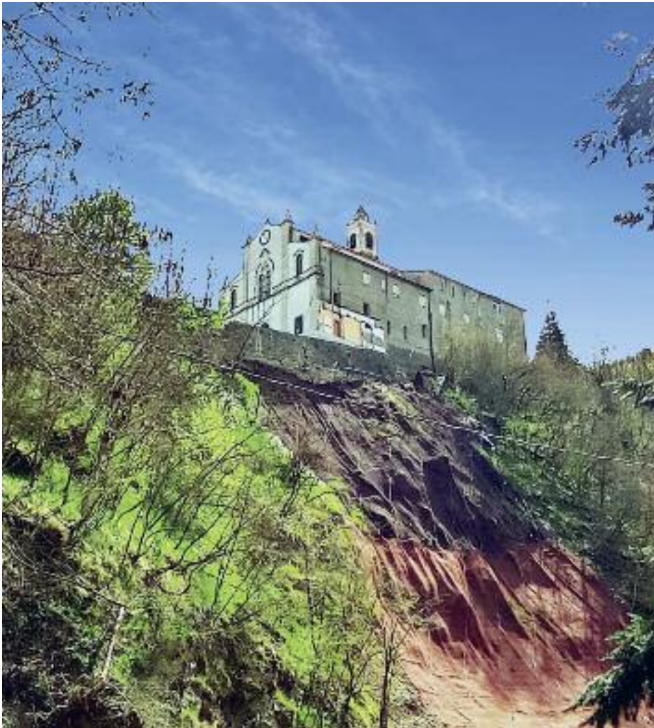
(Foto 001) Molare, Santuario delle Rocche: giace su brecce e conglomerati grossolani della Formazione di Molare. La grossa frana è partita verso la metà del 2019. Le radici delle roveri non hanno potuto trattenere i materiali rocciosi per la marcata acclività e per l’inibizione di intense e prolungate piogge. La copertura con teloni e griglie specifiche proteggerà i terreni dalla violenza delle acque piovane, ma sarà necessario un continuo monitoraggio della struttura.
