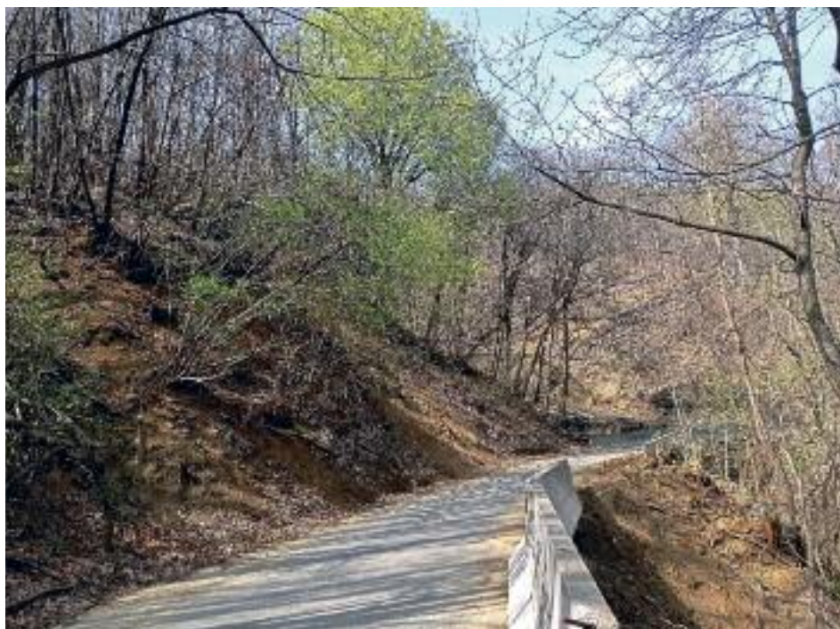
(foto002) Strada Olbicella - Molare. Gli alberi di castagno e di nocciolo hanno radici quasi superficiali e sono pertanto inadatti al consolidamento dei suoli acclivi. L’unico faggio ha trattenuto con il suo possente apparato radicale una buona porzione di terreno costituito da Micascisti sfaticci.
