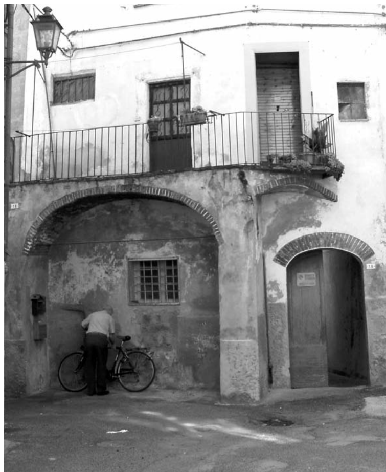
A lato, l'edificio delle vecchia caserma dei Carabinieri Reali posto in P.zza dell'Ulivo in Cernaia
