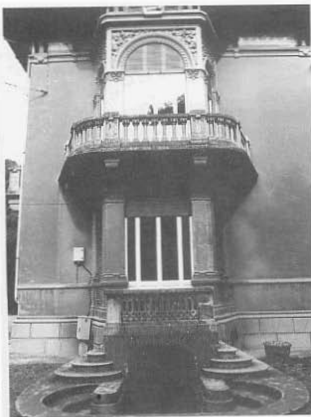
Lato Ovest della villa in un'immagine del 1991.
